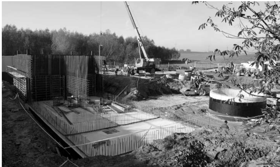
Oczyszczalnia ścieków - największa obecnie inwestycja realizowana w gminie Lipnik.
