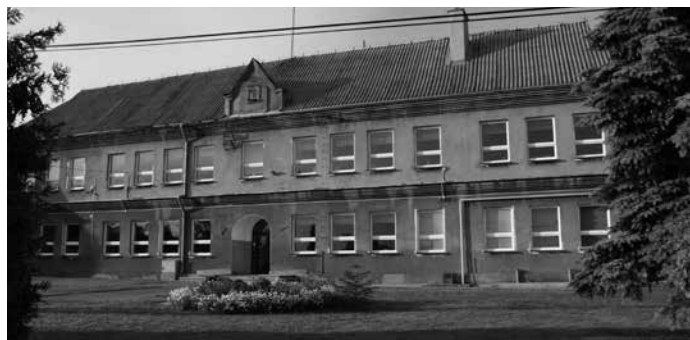
Szkola we Włostowie czeka na termoizolację
