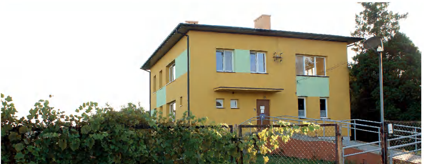
Ośrodek zdrowia w Malicach po termomodernizacji
