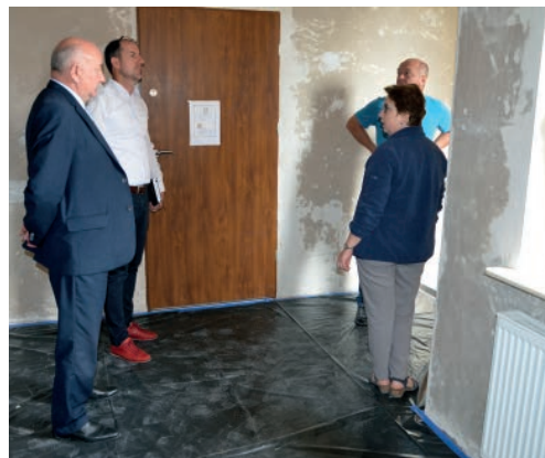
Zakończenie remontu szkoły we Włostowie
