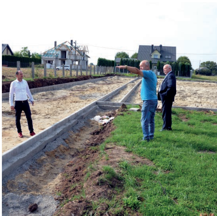
Budowa boiska wielofunkcyjnego przy szkole w Lipniku
