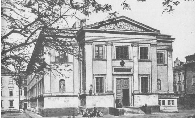
Budynek Wydziału Biologii Szkoły Głównej w kampusie centralnym Uniwersytetu Warszawskiego – pierwotnie, siedziba Gimnazjum Realnego w Warszawie zaprojektowany przez Antonio Corzkiego (źródło: https://pl.wikipedia.org/wiki/Szko%C5%82a_G%C5%82%C3%B3wna_Warszawska )
