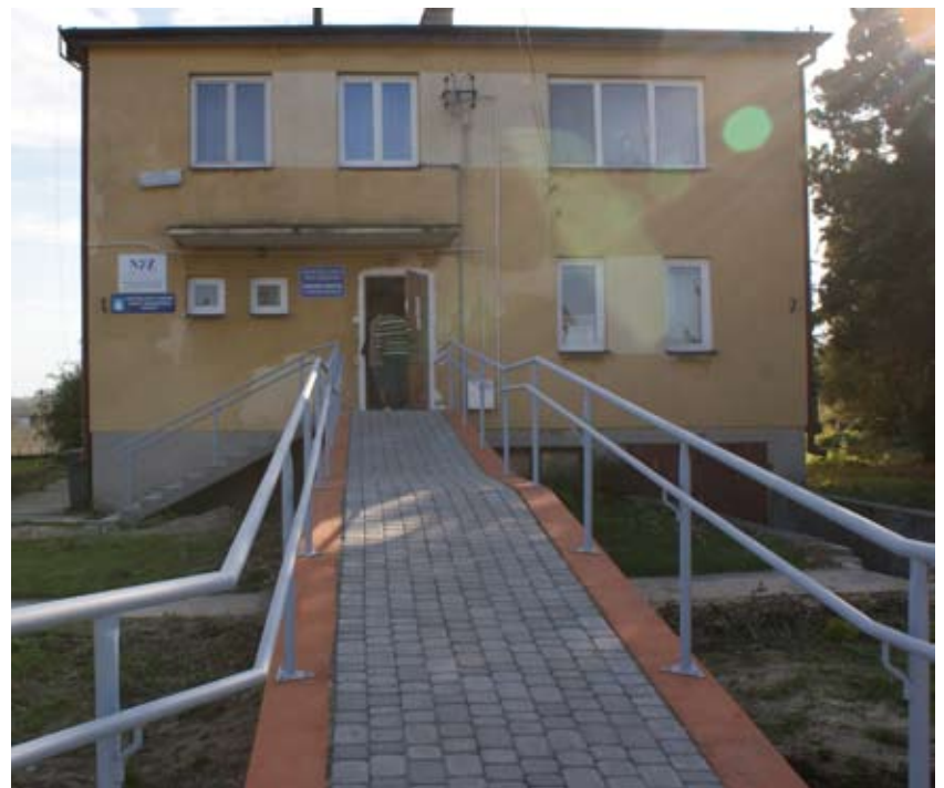
Inwestycje ułatwiające niepełnosprawnym i starszym mieszkańcom gminy codzienna egzystencję (budowa parkingu przy Urzędzie Gminy, podjazd do ośrodka zdrowia w Malicach, winda dla niepełnosprawnych w szkole w Lipniku.
