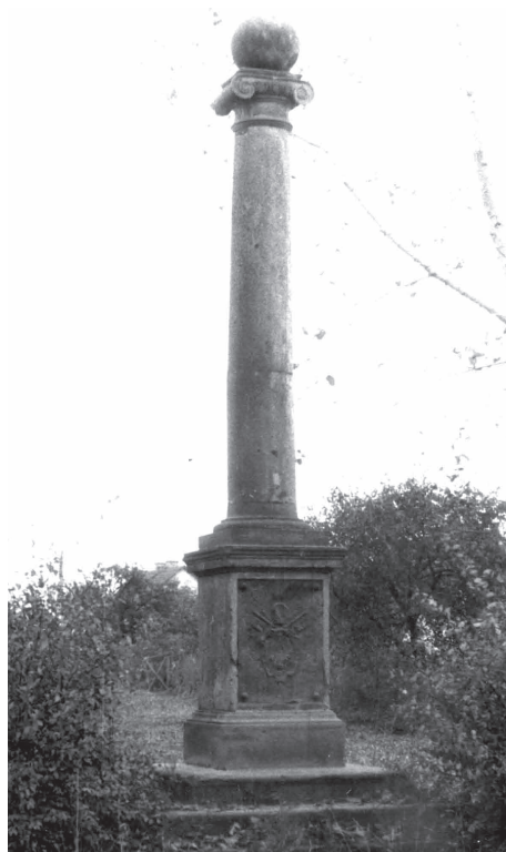
Frontowa część kolumny (oryginalna tablica).
